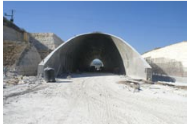
מעבר הרצף (מעבר לבעלי חיים) בשיטת cut and cover
